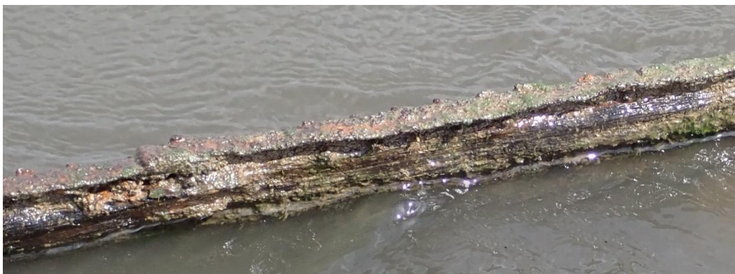
Afbeelding 12 Spijkerkoppen op het plaatstaal (Besselaar).
