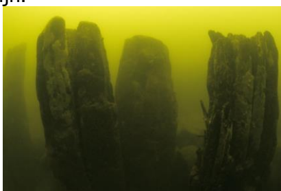
afbeelding 3 Uiteenvallende paalkop, foto 2007 Willem Kolvoort
