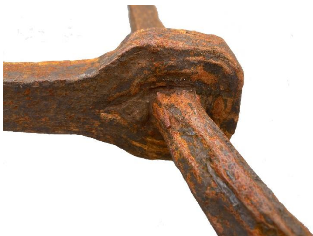
Afbeelding F Verbinding stok en zijarmen muuranker.
