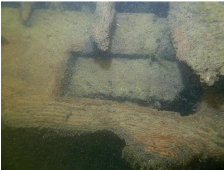
Afbeelding C Bovenaanzicht van de houten paal in de houten balk, met resten van de houten fundering.
