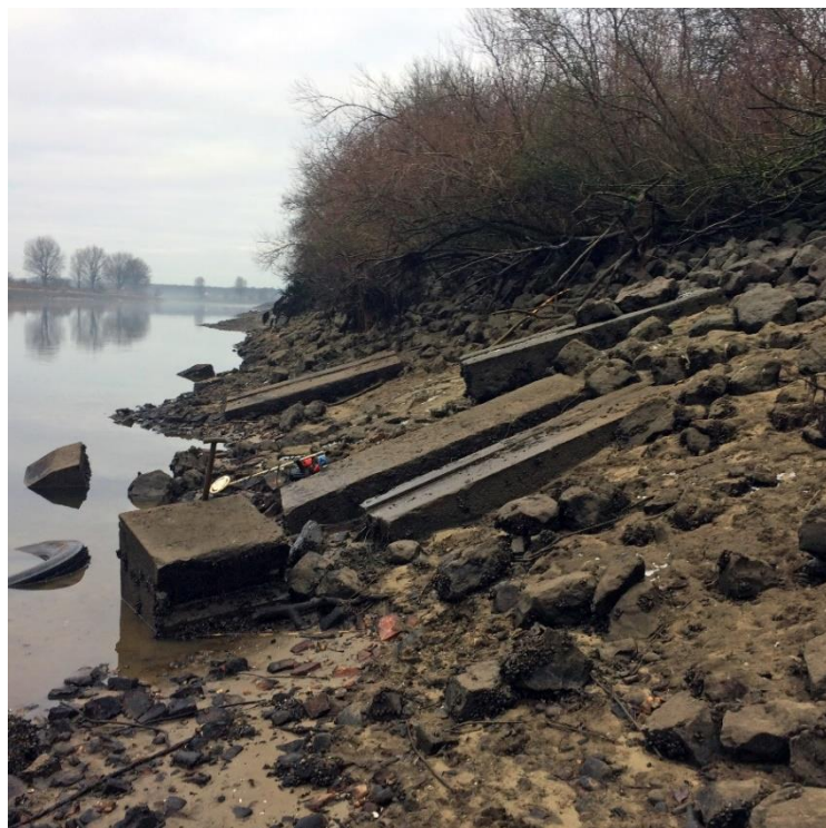
Afbeelding A Het werkgebied bij extreem laag water. Kijkrichting noord.
