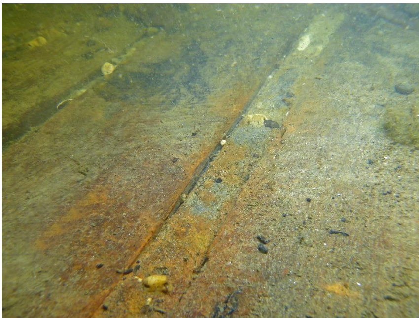
Afbeelding E Vervolg houten fundering richting oever.
