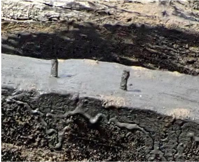
Afbeelding 6 Spijkers in een spant voor de bevestiging van de wegering (Besselaar).
