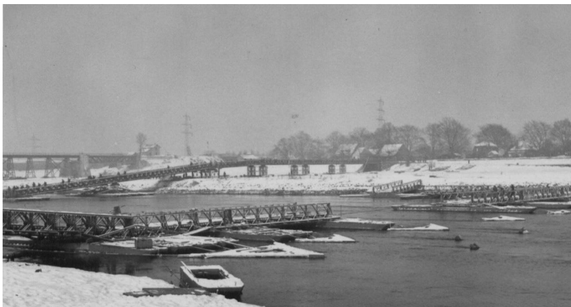
Afbeelding 4 Bailey bruggen over de Maas bij Katwijk, maart 1945 (Foto: BHIC 4 ).
