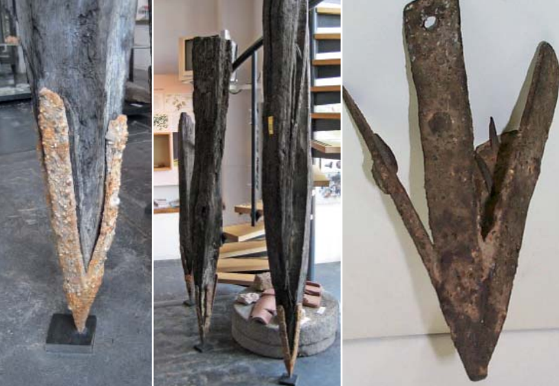
Boven: Heel karakteristieke onderdelen van de aangetroffen funderingspalen zijn de smeedijzeren paalshoenen die werden aangebracht om de punt van de heipaal te beschermen bij het inheien in het zand- of grindbed van de rivier. Opnamen gemaakt in Museum Ceuclum te Cuijk bron: Museum Ceuclum, foto's auteur
