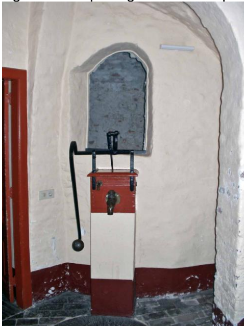
Figuur 4 Putopening met de handpomp.
